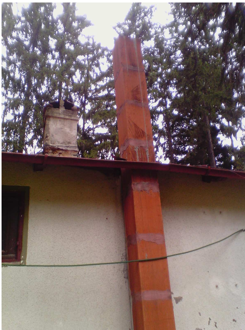
Foto 3 – Tabara Cozia – vedere cos centrala Vila Basarab
